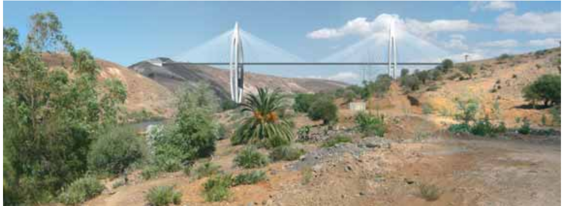
Cable-stayed bridge across the Bouregreg Waddy (Rabat) Pont à Haubans de franchissement de l'Oued Bouregreg (Rabat) Puente atirantado de franqueo de Oued Bouregreg (Rabat)
