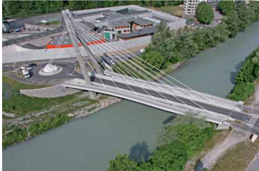
Structure across the Arve in Bonneville Ouvrage de franchissement de l'Arve à Bonneville Obras de paso desde Arve a Bonneville
