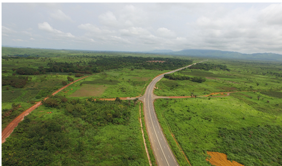
Vue aérienne de la route RN1 achevée © Egis / XU Hui – CSCEC
